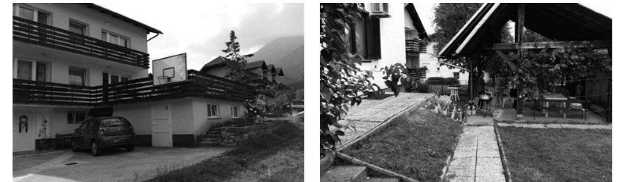
Hiša stanovanjske skupine Črnava in večnamenski zunanji prostor SS Kranj
