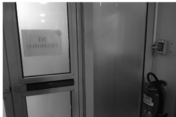
Vhod na varovani oddelek v enoti Muretinci
